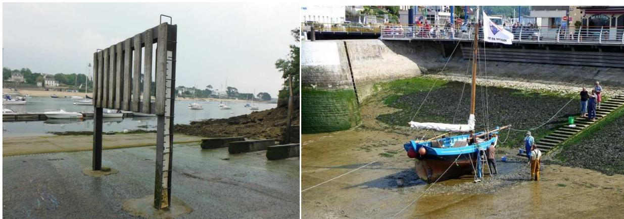
Photo 8 : Grill de carénage sur la cale de mise à l'eau au port de Sainte-Marine (29)
