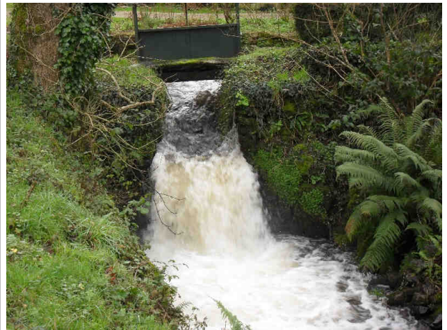
Vannage moulin de Tromelin
