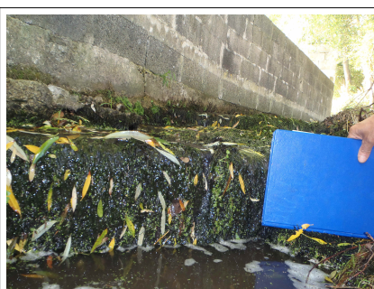
Seuil franchissable par les anguilles
