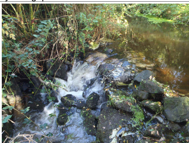
Ouvrage du moulin de Poulbleis
