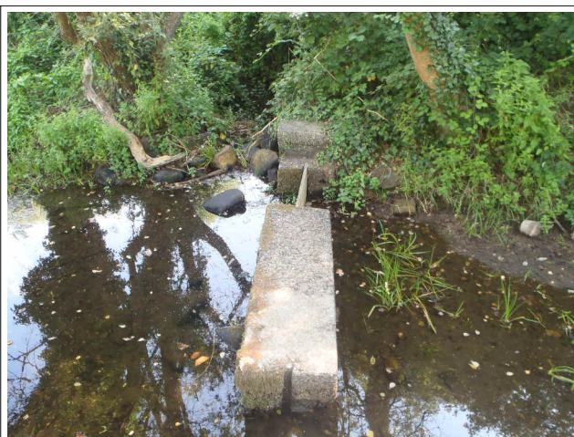
Lavoir permettant la répartition des débits
