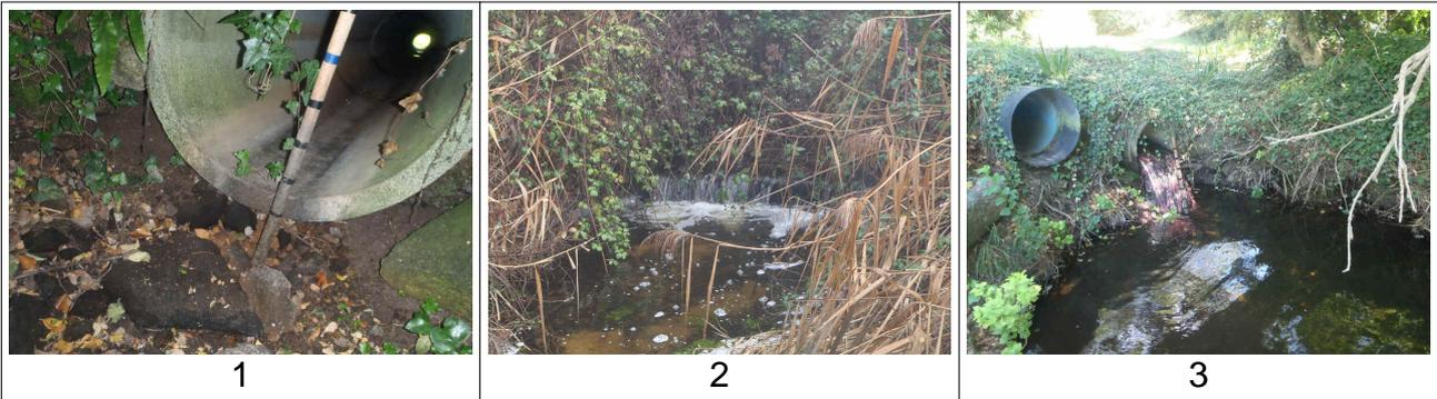
Obstacles à la continuité écologique : 1 : Buse présentant une chute à l'aval (Moulin de la Palue) ; 2 : chute à l'aval et seuil vertical (réserve d'eau agricole) ; 3 : présence d'une voie plus facile pour la reptation par l'intermédiaire du réseau racinaire (Pors Dibord)
