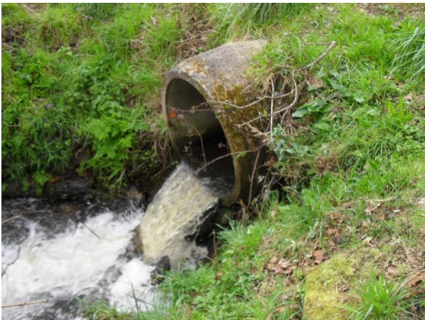
Le site avant travaux (hiver 2021)
