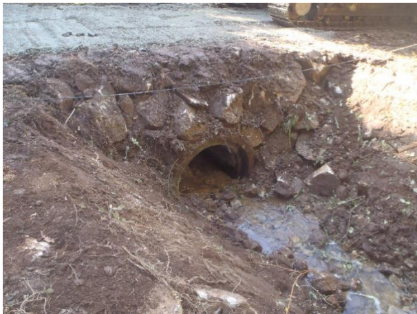
Le site après travaux (octobre 2021)
