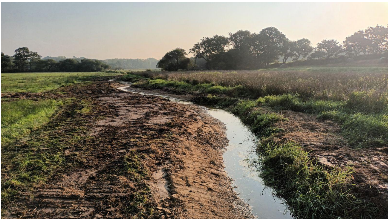
Exemple : travaux réalisés en amont du projet en 2024
