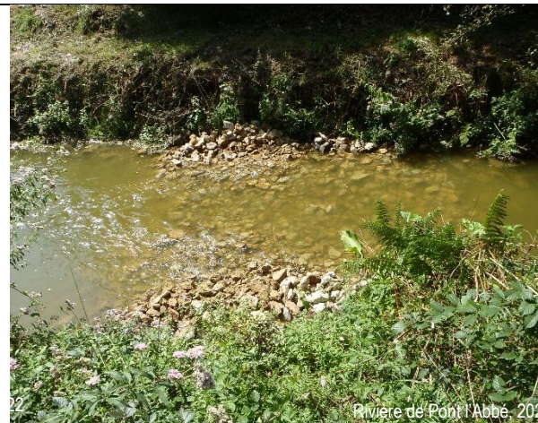
Exemples réalisation 2024 rivière de Pont l'Abbé : banquette minérale, radier
